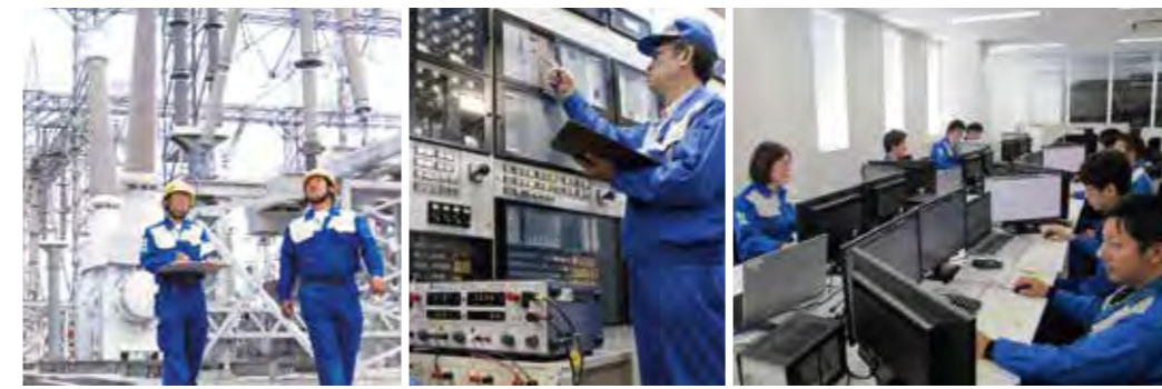
● 変電設備の建設、保全 ● 制御設備の建設、保全 ● データベースメンテナンス
