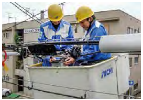
● 伝送路設備の建設、保全
