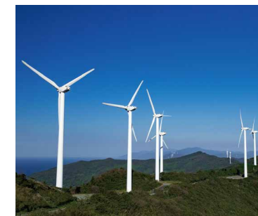
風力発電設備
