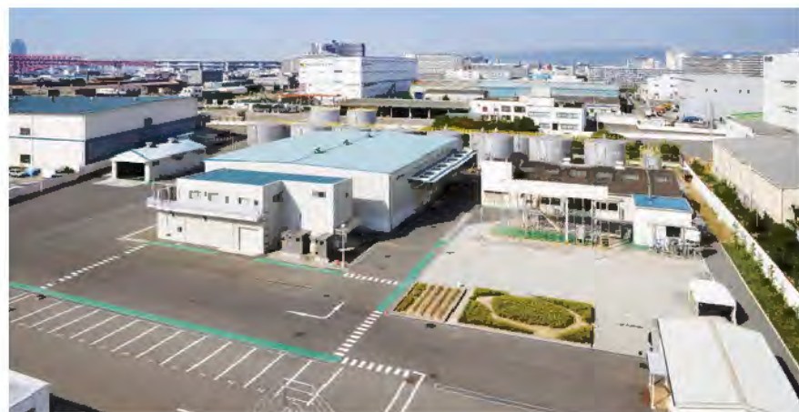
●世界最高品質の電気絶縁油「サンオームオイル」を生み出す自社工場
