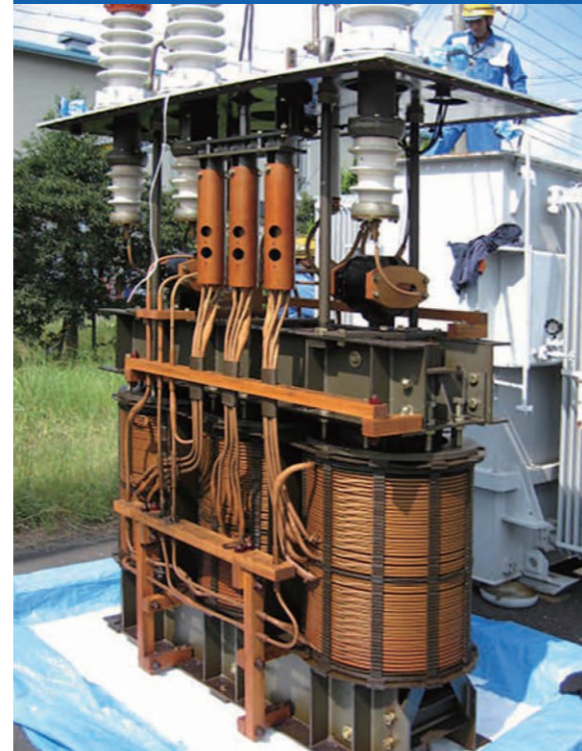
変圧器内部点検
